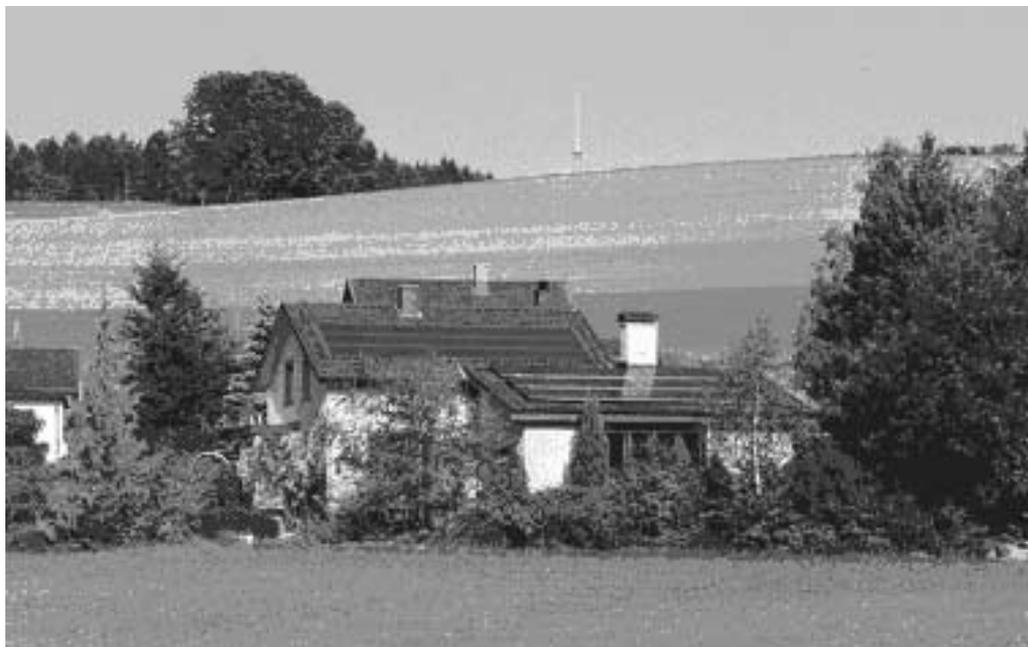
*Solarhaus Fam. Leutwiler, 5737 Menziken: Hausdach mit therm. Sonnenkollektoren für Warmwasser 19.6 m<sup>2</sup>, Dach vom Anbau mit Solarzellen 3 kW-Netzverbundanlage zVg*
