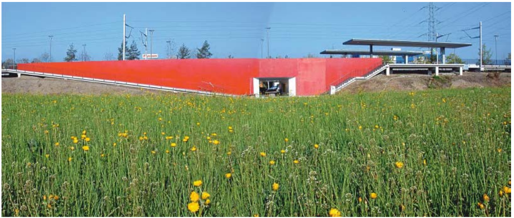
Markante Haltestellen der Stadtbahn Zug weisen den Weg / Des arrêts remarquables pour les transports ferroviaires de la ville de Zug zVg
